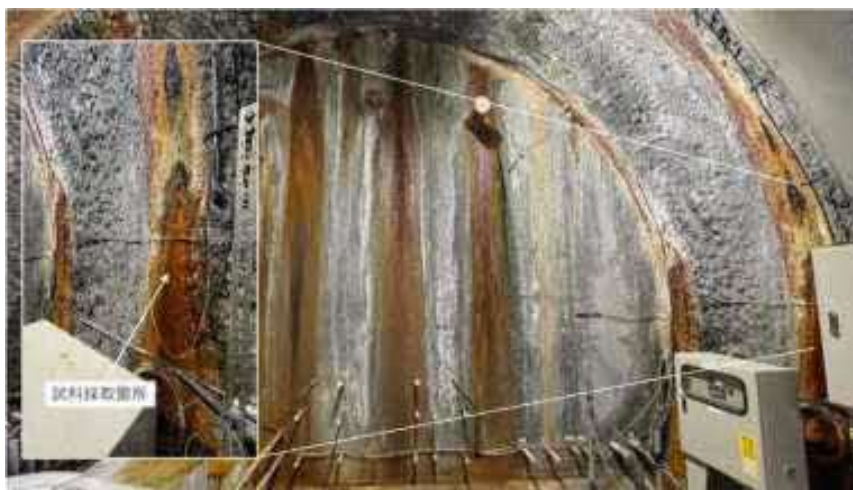
図 101 試験坑道 4 壁面からの浸出水の採取箇所 写真の奥に見えるのは、人工バリア性能確認試験のコンクリートプラグです。
