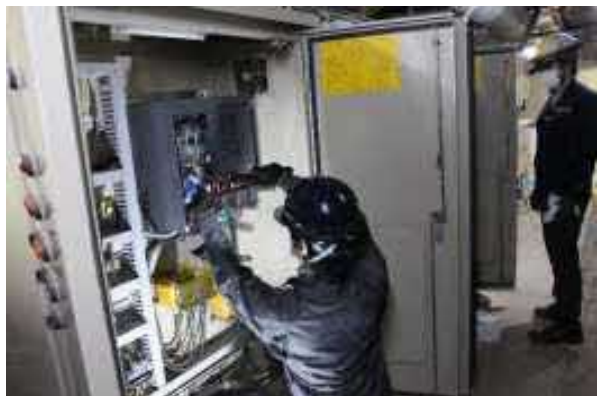
(b) 排水設備の更新
