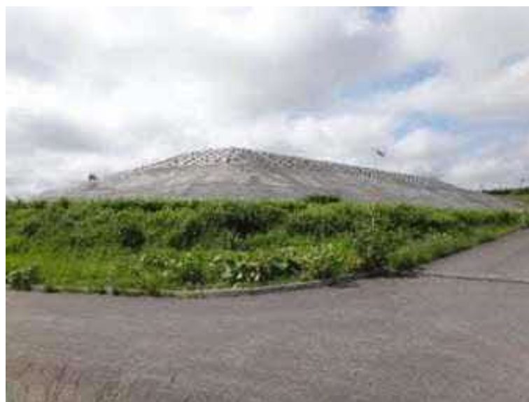
図 122 掘削土（ズリ）置場
